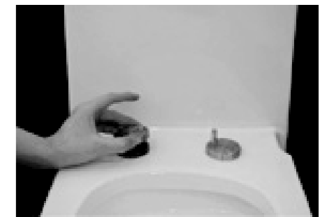
Cover the stainless steel lid. Cubrir la tapa de acero inoxidable. Couvrez le couvercle en acier inoxydable.
